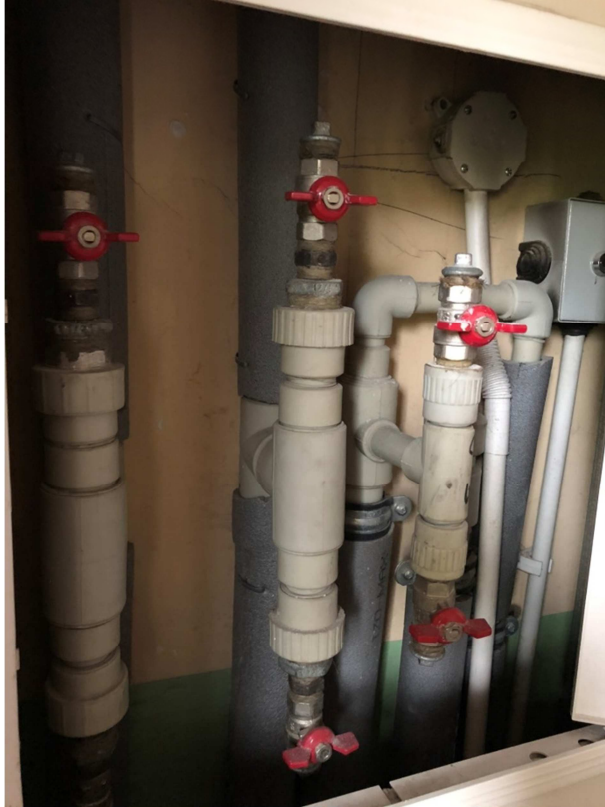
Szacht instalacyjny na poddaszu budynku frontowego.
