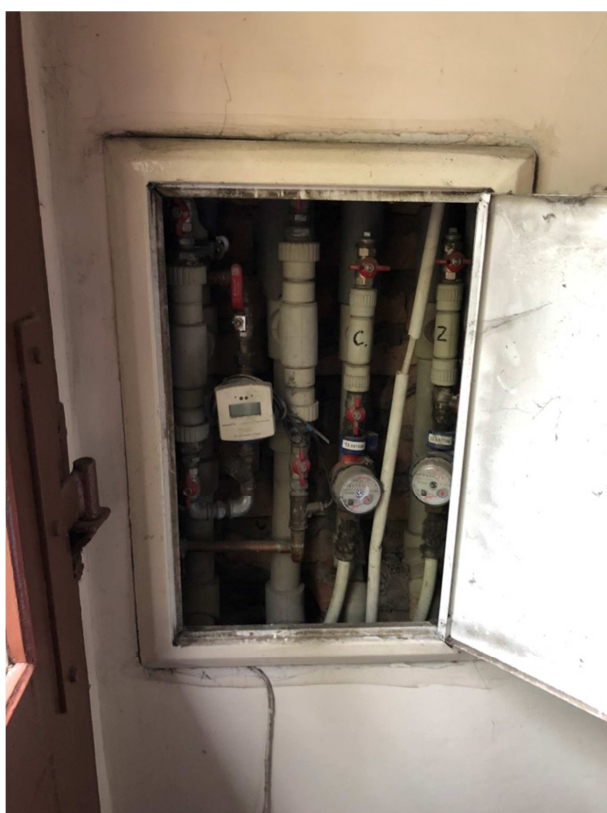
Szacht instalacyjny na parterze w części frontowej budynku.
